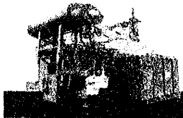
หม้อแปลงไฟฟ้ากำลังแบบปรับเปลี่ยนแรงดัน โดยอัตโนมัติ ระบบ 22 kV (Automatic Voltage Regulator (AVR) for 22 kV) - ขนาด 16 MVA (400 A) 11,277,000 บาท/เครื่อง
